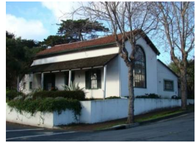
Casa de la Torre (1852) 502 Pierce Street
