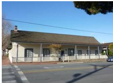
Casa Abrego (1834) 592 Abrego Street
